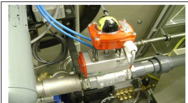
Druckluftgesteuerte **Entleerungsventile** für schnellen Wasserrücklauf
